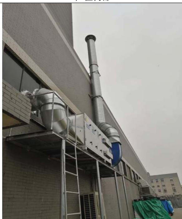
吹膜废气处理装置
