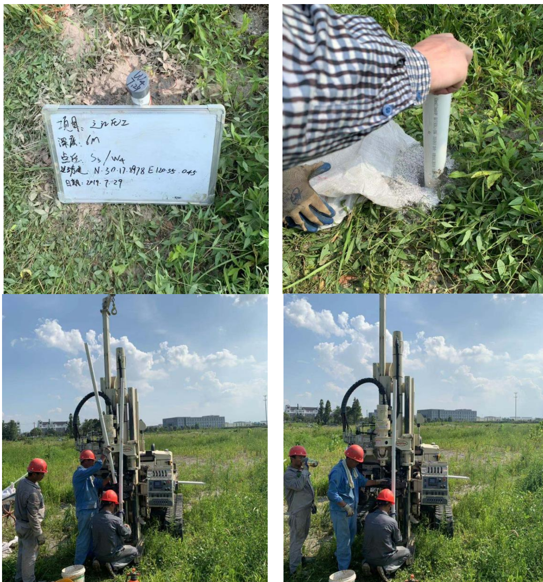
图5.1-4 Geoprobe地下水井安装施工
