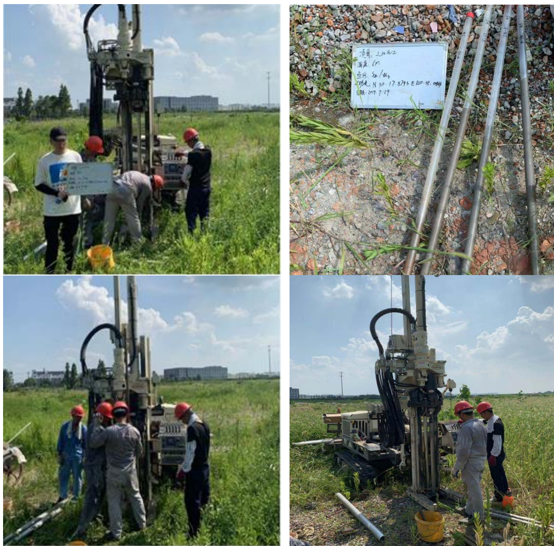
图5.1-5 Geoprobe土壤采样施工
