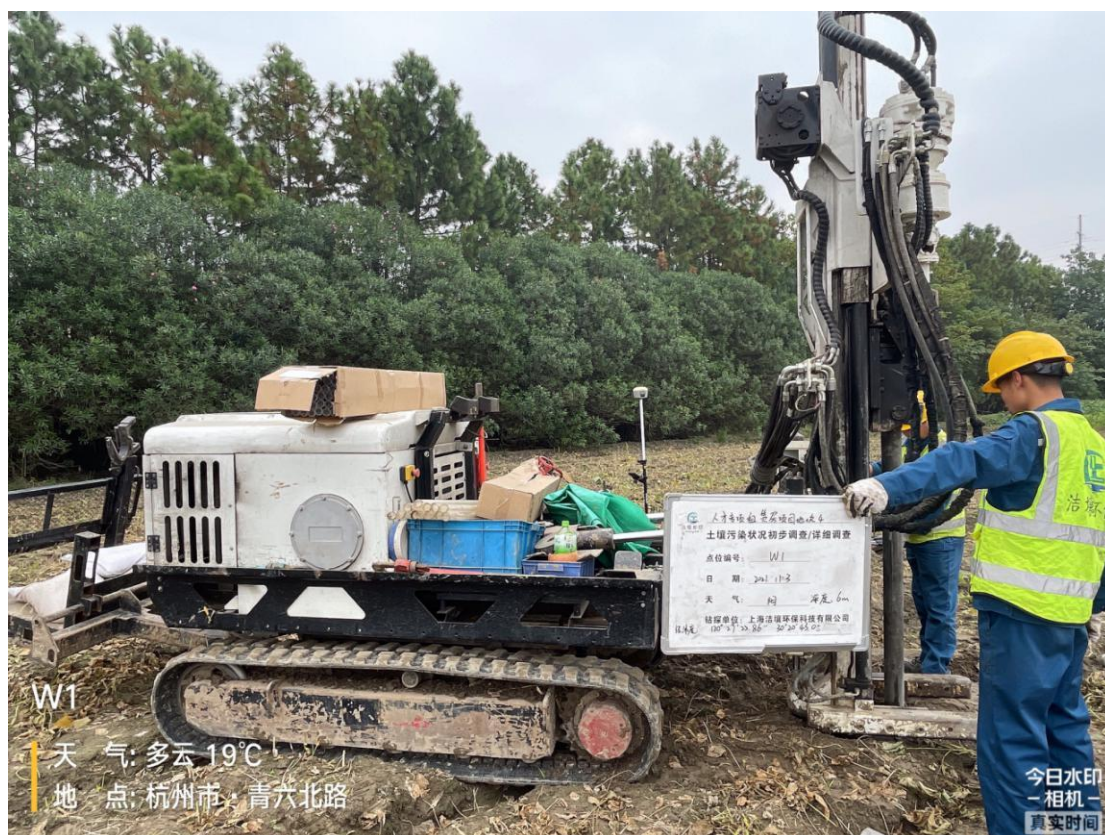
图5.2-4 地下水建井下管照片
