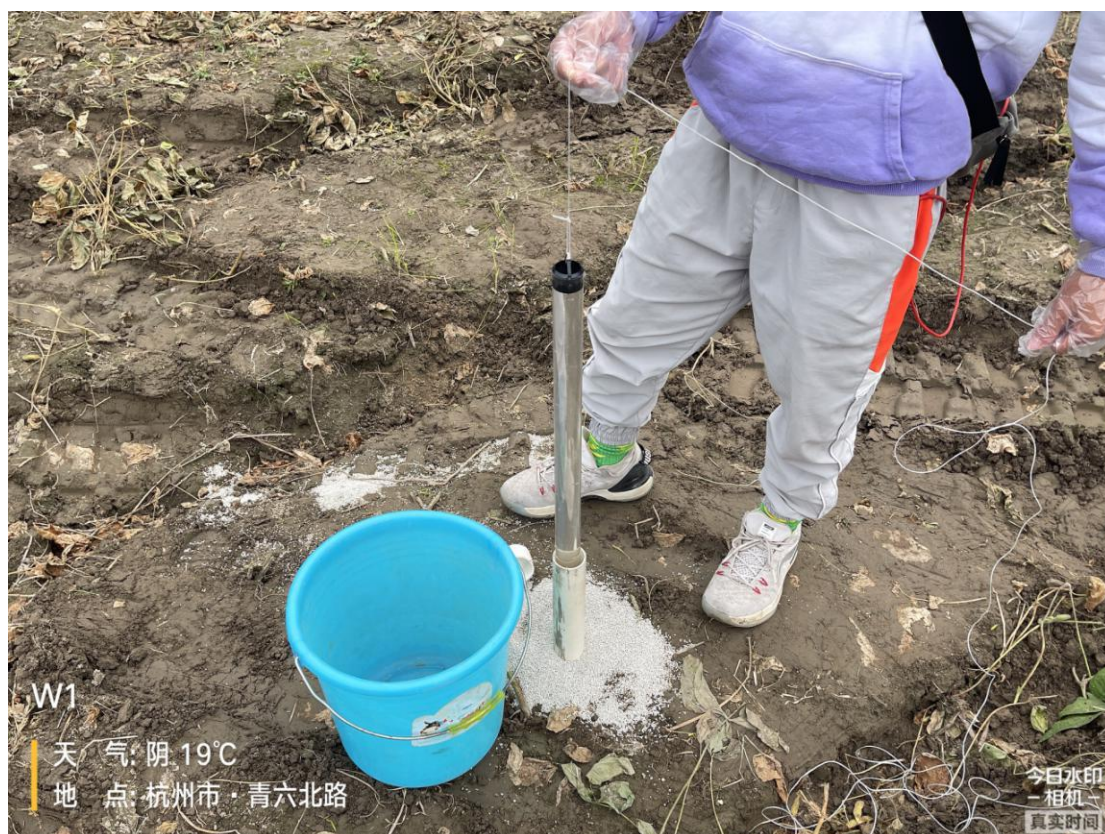
图5.2-7 建井后洗井照片
