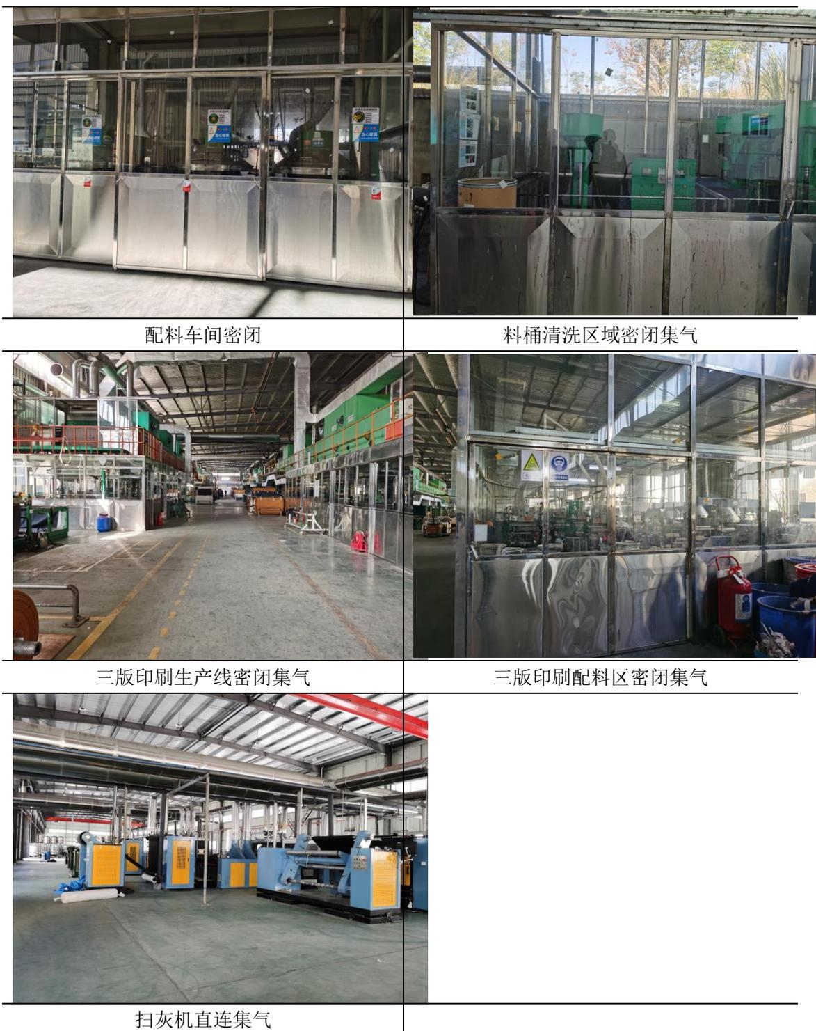
图 4-2-3 配料区、清洗区和后整理区废气收集
