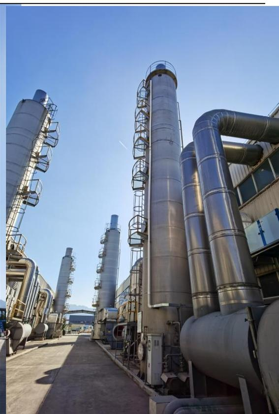
无溶剂和溶剂超细纤维干法线废气喷淋塔
