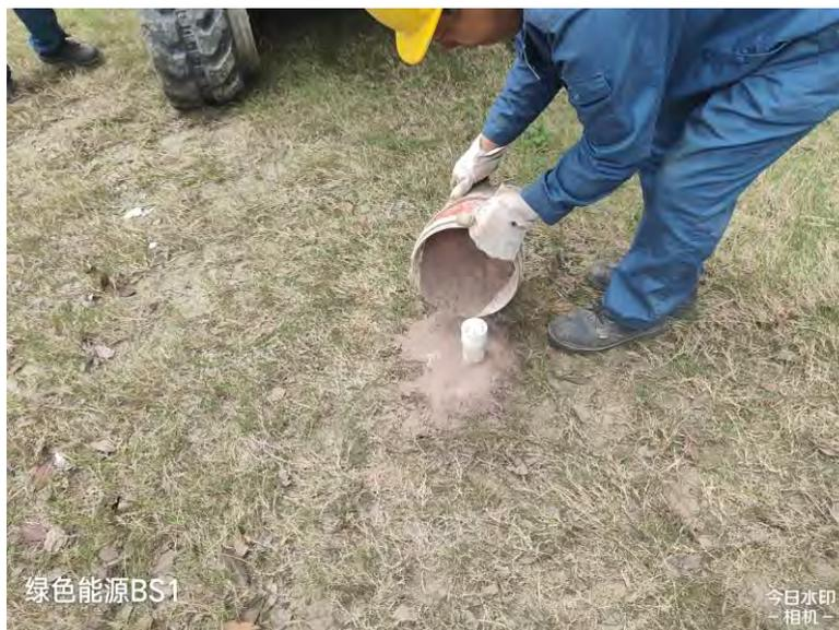
图7.2-3 密封止水照片
