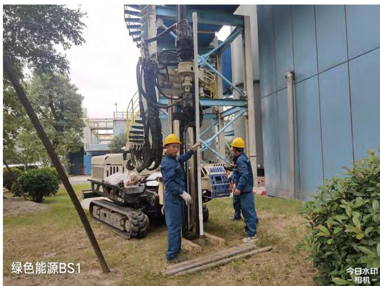
图7.2-1 地下水建井下管照片
