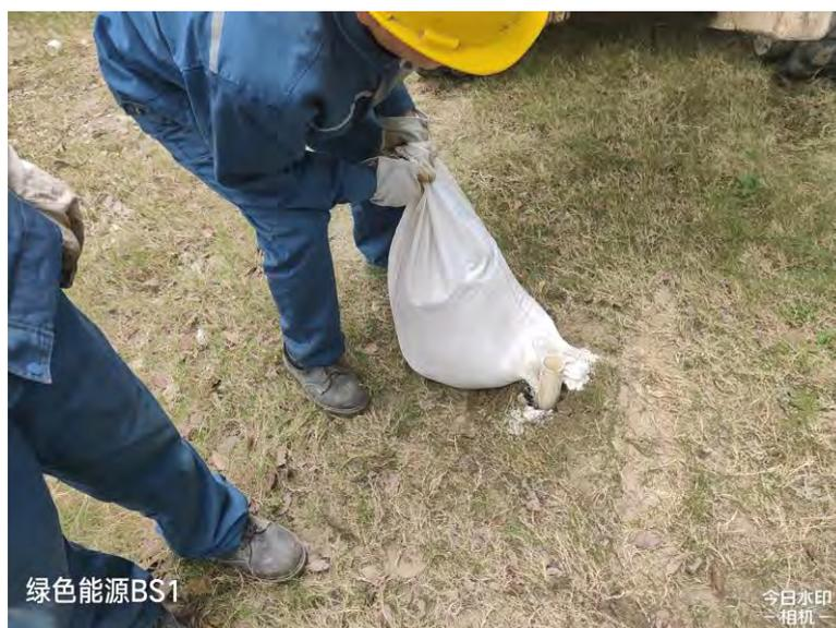
图7.2-2 滤料填充照片
