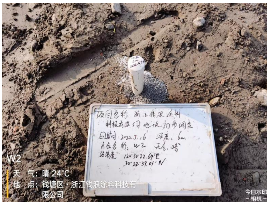
图5.2-6 密封止水及采样井照片
