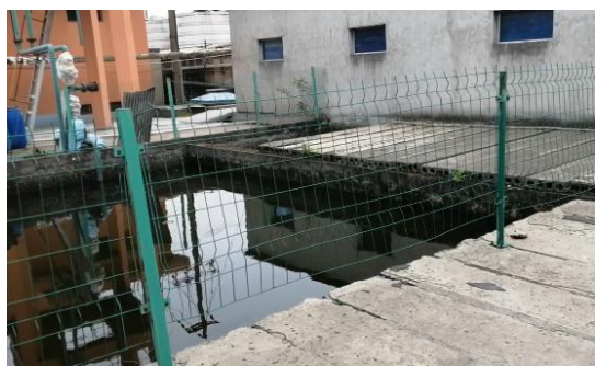
消防水池/污水池
