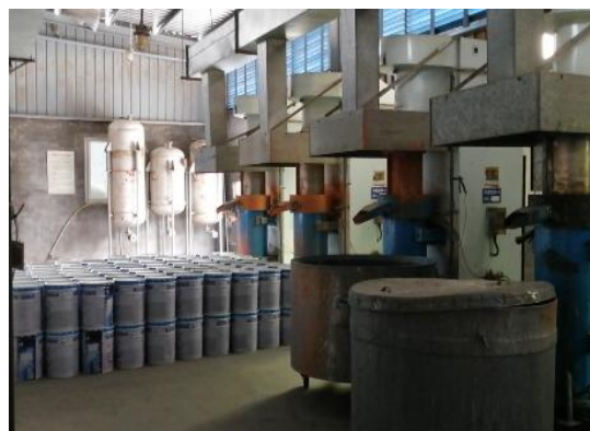
生产车间（丙类）
