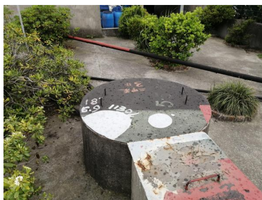
埋地罐区（未启用）
