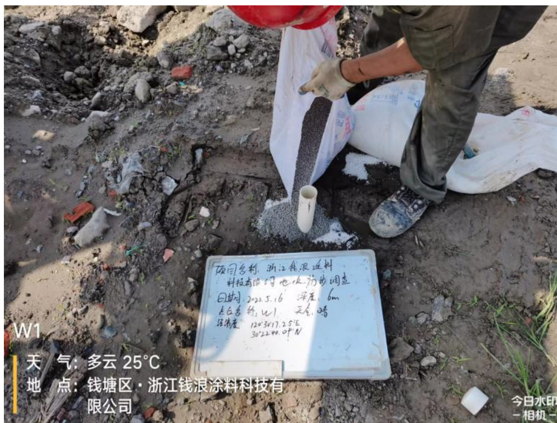
图5.2-5 滤料填充照片
