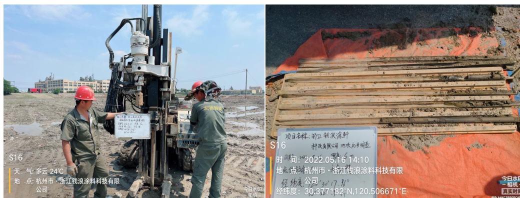
图5.2-1 土壤钻探取样现场照片
