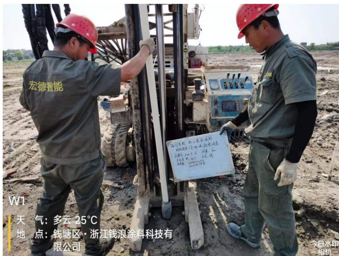
图5.2-4 地下水建井下管照片
