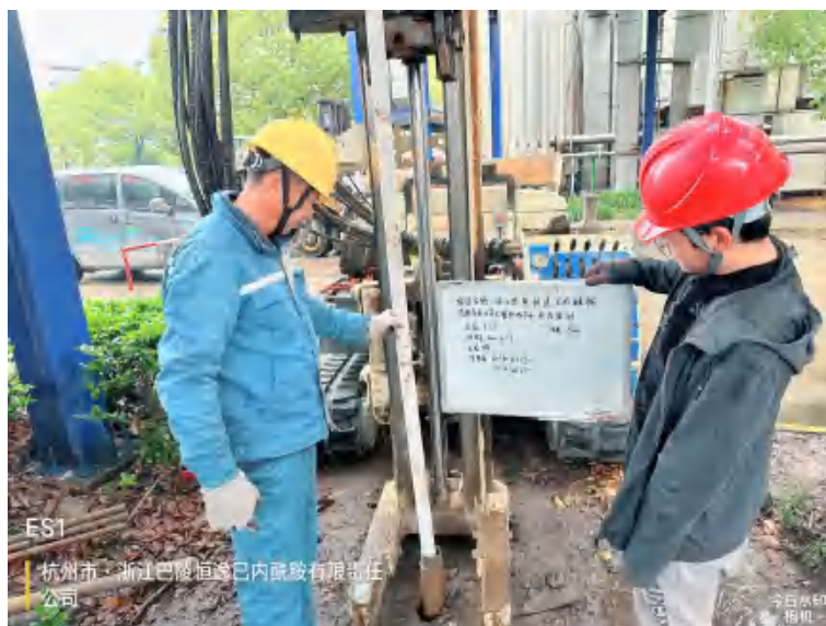
图7.2-1 地下水建井下管照片
