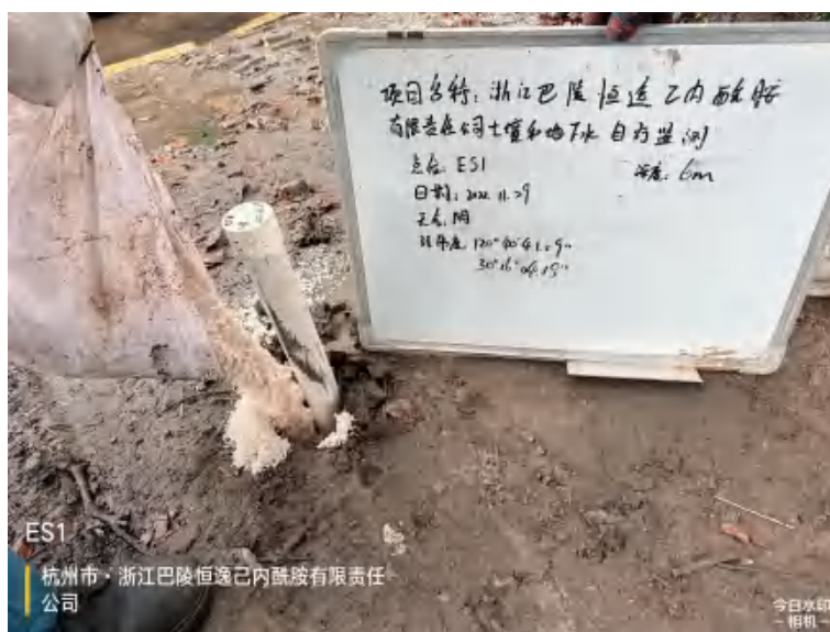
图7.2-2 滤料填充照片
