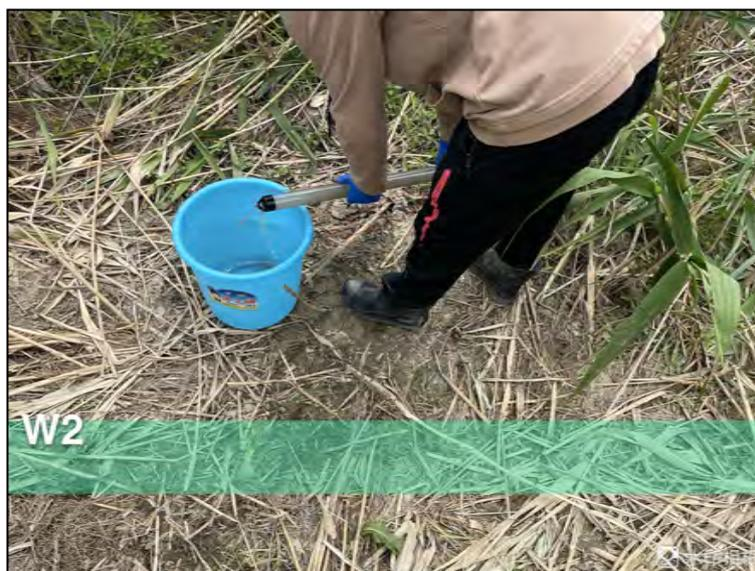
图 5.2-7 建井后洗井现场照片
