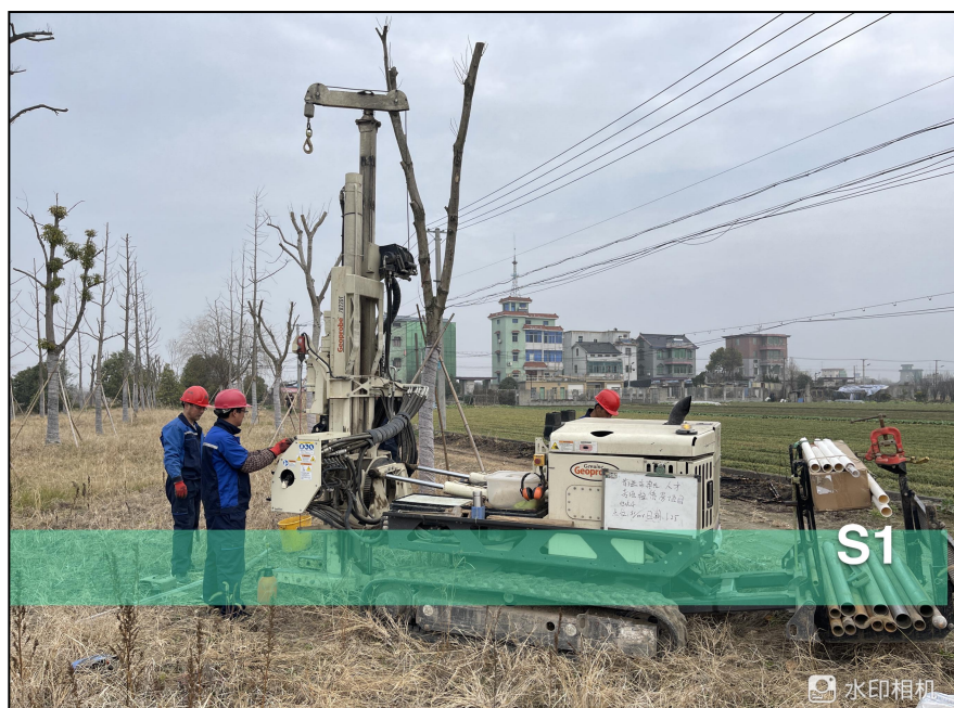
图5.2-1 土壤钻探取样现场照片
