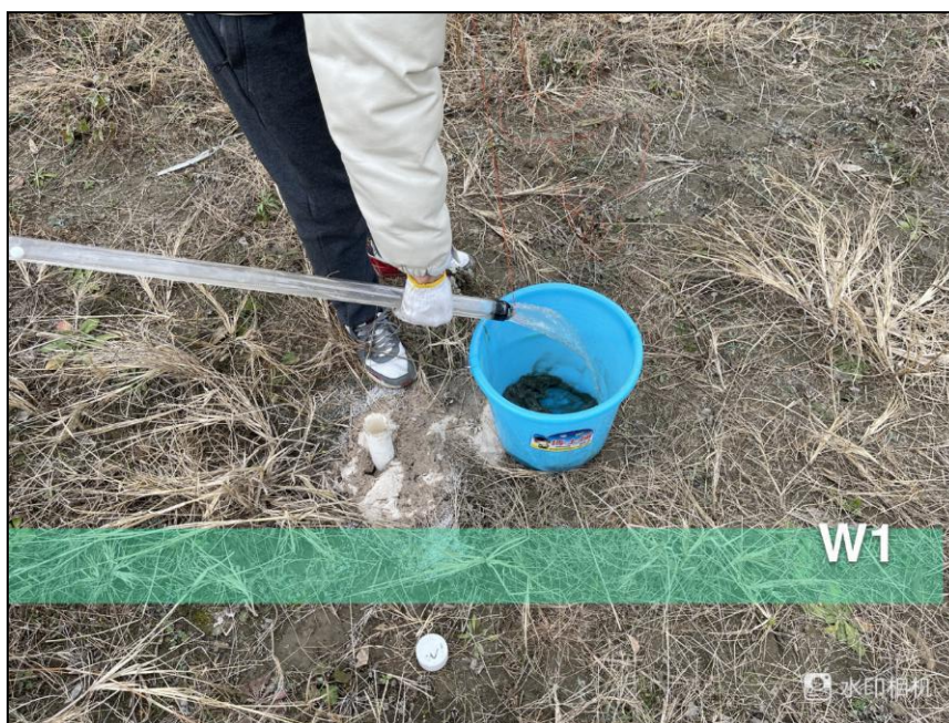
图 5.2-7 建井后洗井现场照片
