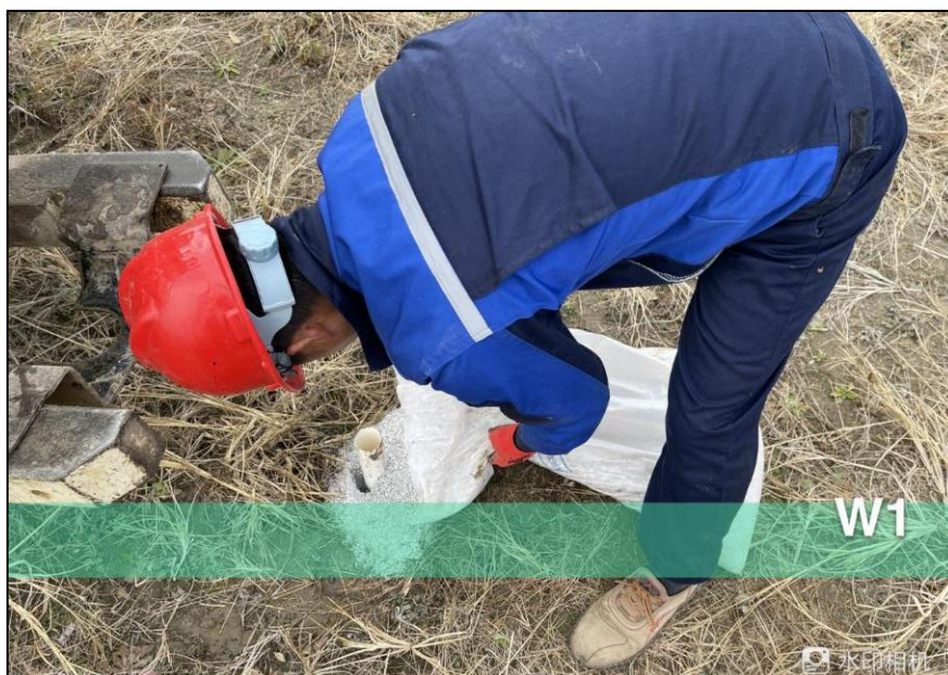
图 5.2-5 滤料填充现场照片
