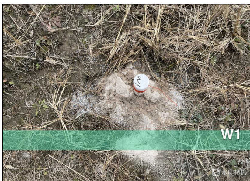
图 5.2-6 膨润土和水泥密封现场照片
