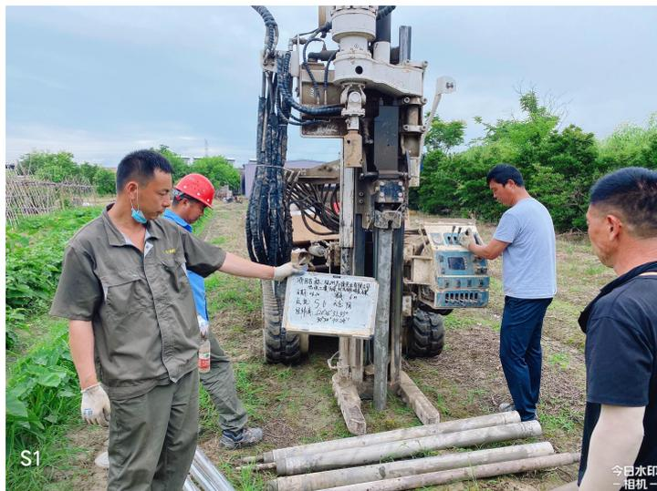
图5.2-1 土壤钻探取样现场照片
