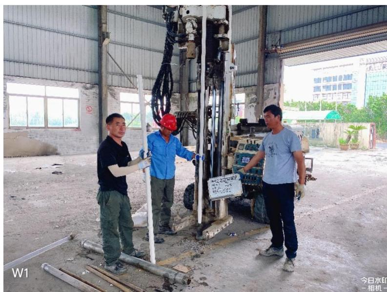
图5.2-4 地下水建井下管照片
