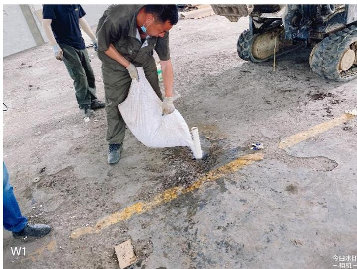
图5.2-5 滤料填充照片
