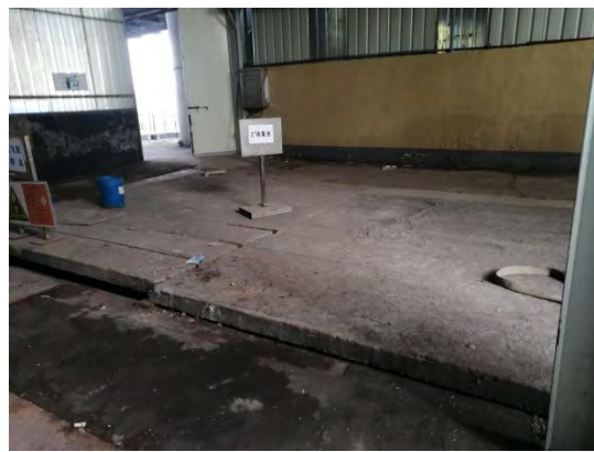
危废仓库内收集池
