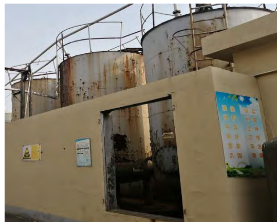
原料贮罐区 (渣浆储槽)
