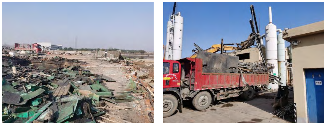
图 3.6-12 拆除过程现场照片
