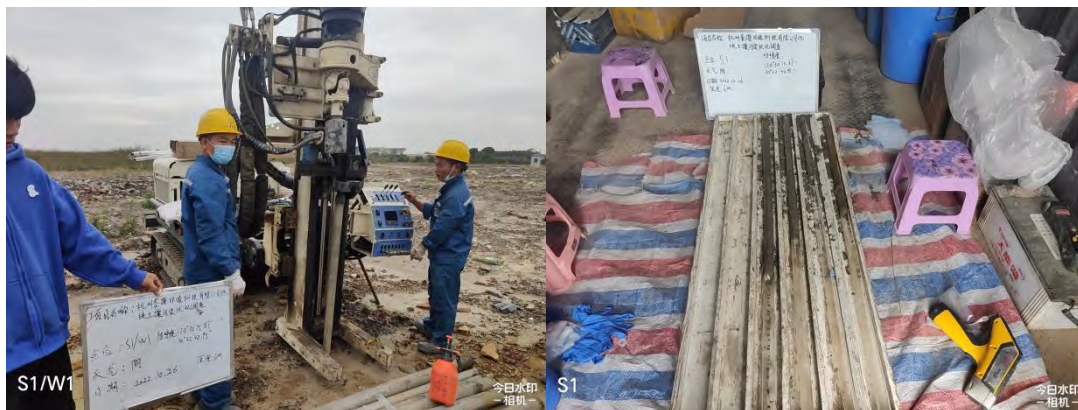
图5.2-1 土壤钻探取样现场照片
