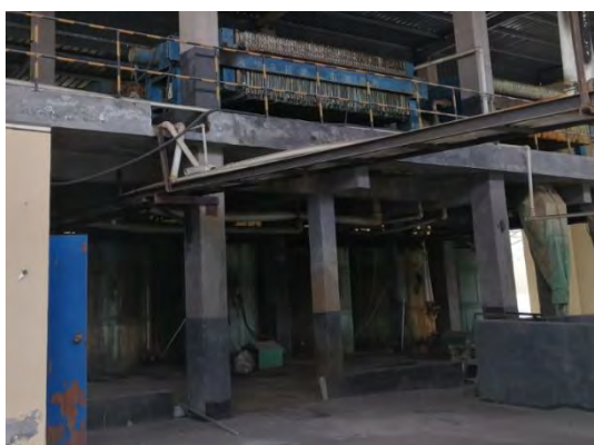
絮凝车间内反应釜
