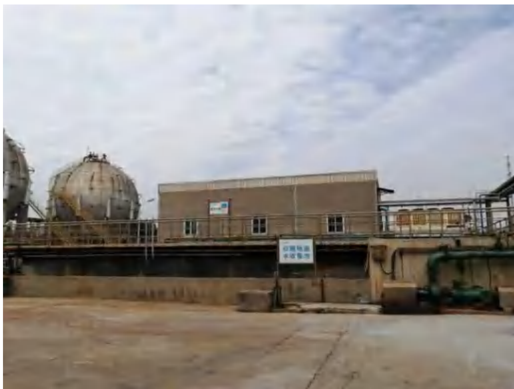
图 4.6-2 初期雨水收集池
