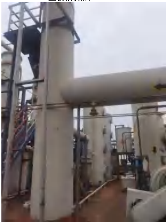
二级酸喷淋(氨)，四级碱吸收(回收亚硫酸钠)+二级碱吸收，DA012
