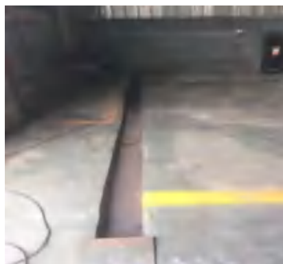
1#危废仓库(污泥库)导流沟
