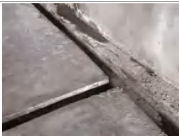
危险废物贮存库 2 截流沟
