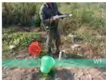
图1-4-2-1 建井后的洗井
