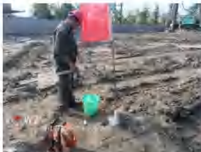
图1-4-2-1 建井后的洗井
