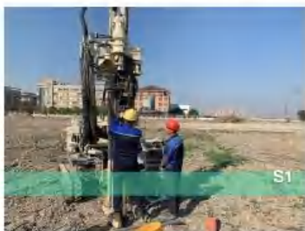
图1-3-4-2 地块内钻孔采样照片
